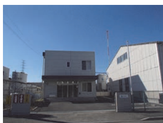
日本液炭株式会社 関東総合ガスセンター
