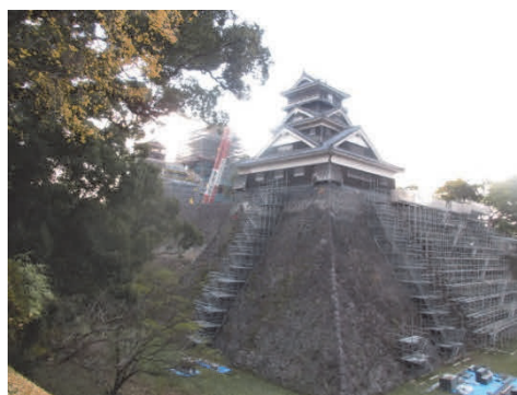
復旧工事が進む熊本城
