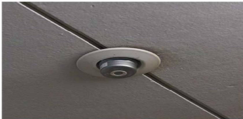
(ヘッドの感熱部が天井面と同一平面に設置しない例)
